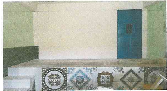
Foto 4: Pared para el fondo del escenario, ampliación de gradas y baranda para subir al mismo.
