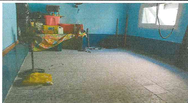
Foto 3: Piso para salón de clases 3
