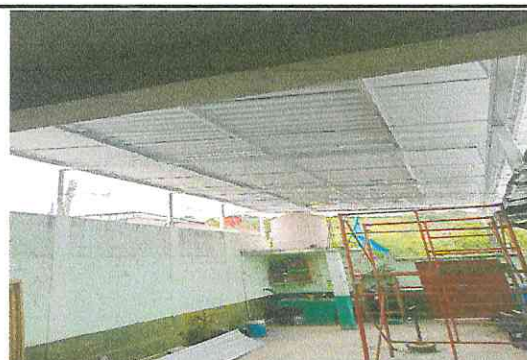
Foto 6: Techo de lámina para patio
