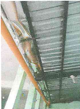
Foto 3: Reparación de canales.
